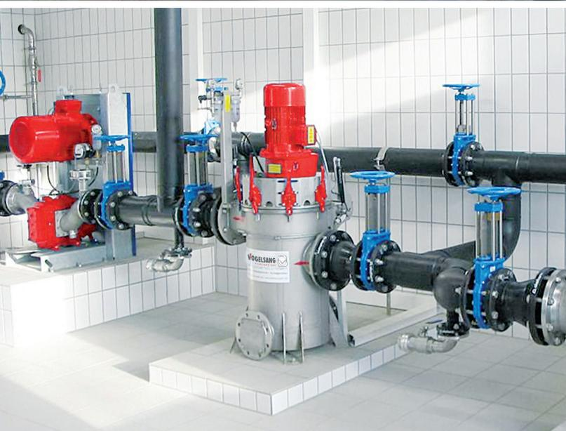
Tandis que le flux du liquide traverse en continu le RotaCut, les matériaux lourds comme les pierres ou les pièces métalliques sont séparés par la gravité, tandis que les fibres et les matières solides sont dilacérées et le fluide homogénéisé.
